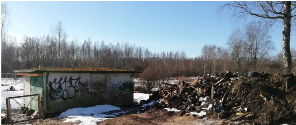
2.6. attēls. Fotofiksācija. Degradētas būves un būvgruži Detālplānojuma teritorijā
