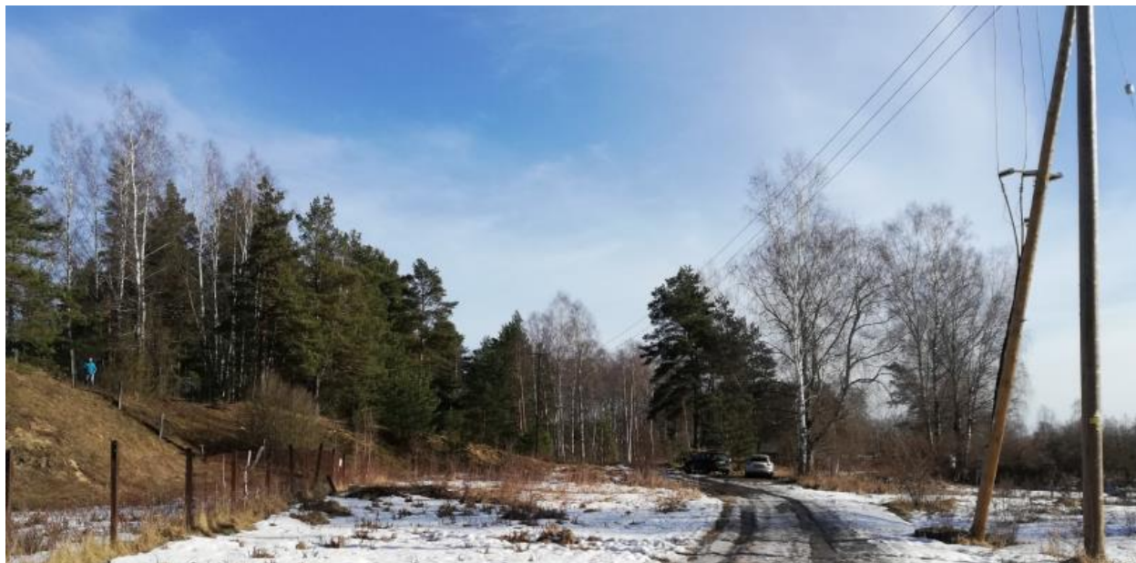
2.14.attēls. Fotofiksācija. 0,4 kV elektropārvades gaisvadu līnija gar Kalnu ielu
